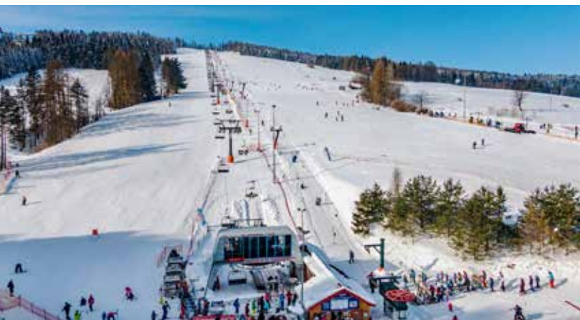
Kompleks Narciarski Slotwiny, fot. A. Klimkowski
