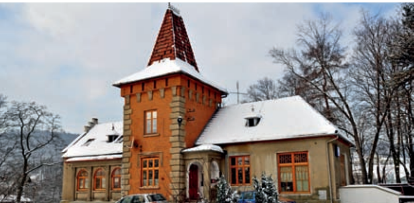
Dwór w Dąbrowie, The manor house in Dąbrowa • fot. A. Klimkowski
